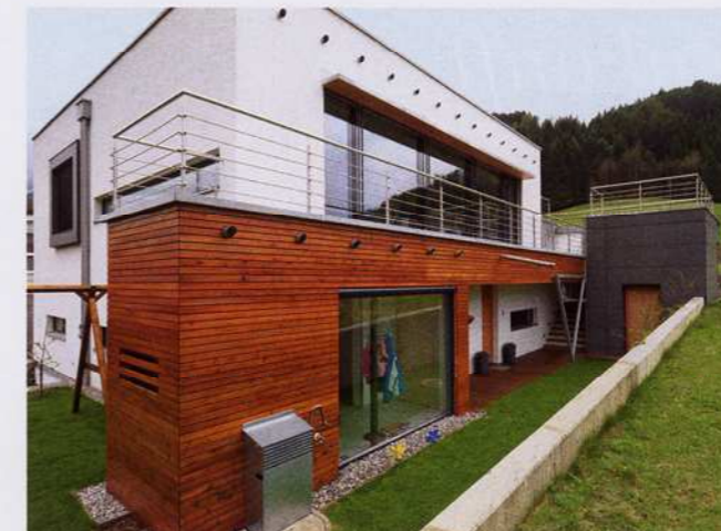
Eingang unter der Terrasse, oben: Rohre zur Dachdurchlüftung.
